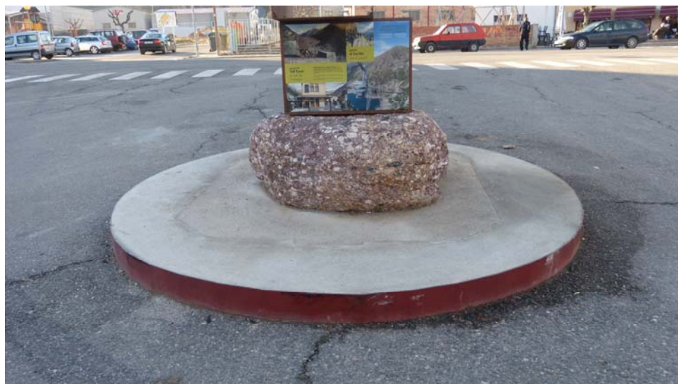
Figura 5.3.4.2. Base de formigó del panell de benvinguda al Geoparc.
